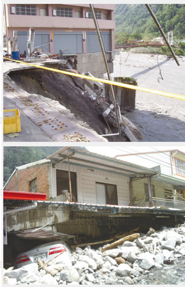
圖1 敏督利颱風過後房舍被土石淹埋與地基被淘空情形
