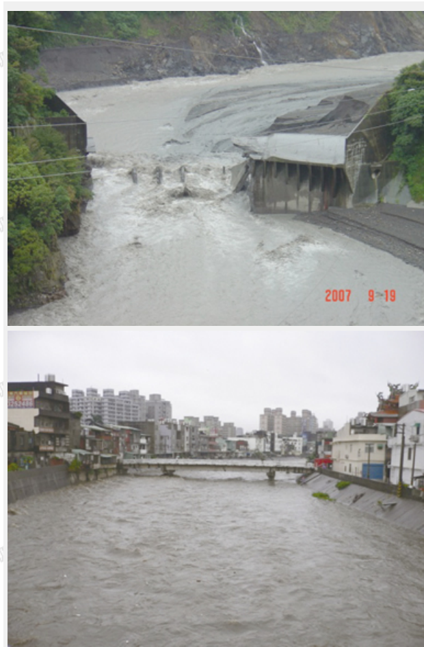
圖2 颶風期間水工結構物損壞（左）與水位暴漲（右）情形
