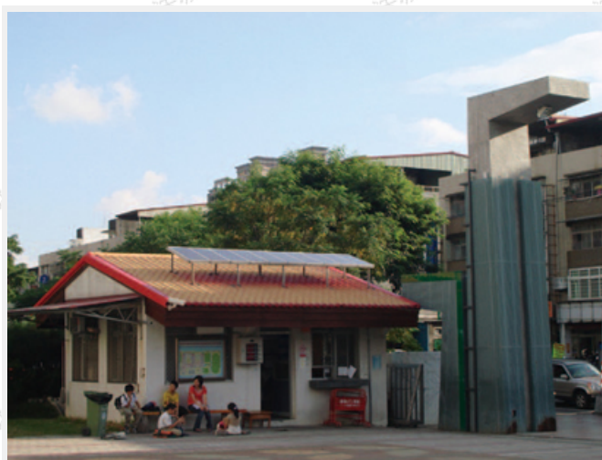
高雄市加昌國小利用傳達室屋頂建置太陽能光電系統，同時提供發電、隔熱遮蔭的場域
