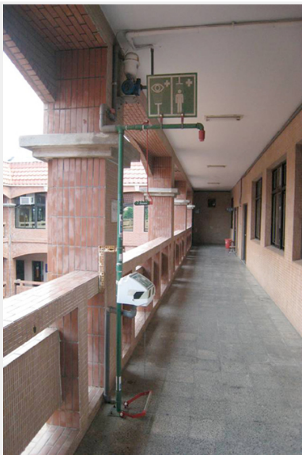
緊急沖淋洗眼裝置是各實驗場所不可或缺的急救設施。 設置地點需為實驗場所附近，地面排水功能需完善且定期維護保養
