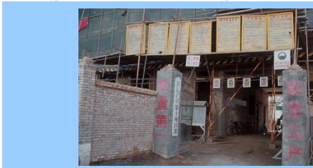
陝西一處建築工地，入口處兩側寫著「安全生產，質量第一」，上方懸掛著各項遵守事項。
