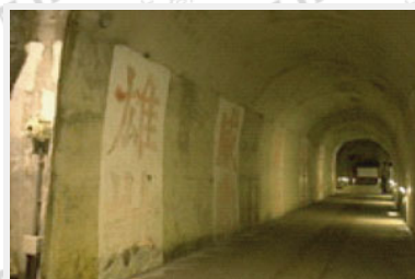
安東坑道斜插於山壁之內，國軍刻苦備戰的生活歷歷在目
