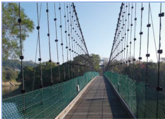
明德水庫吊橋
