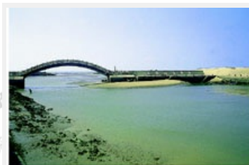
圖4 飛沙越過防波堤並侵入漁港航道(苑裡鎮漁港)。
