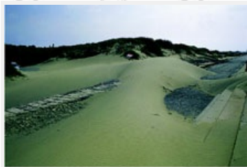
圖3 被沙掩埋的道路(苑裡鎮出水)。
